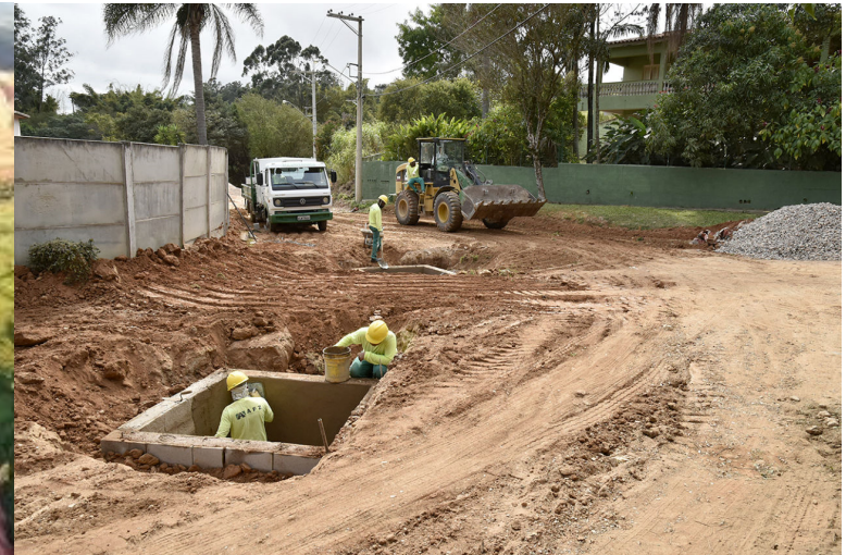
Risco de queda em valas
