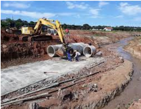
Risco de atolamento de veículos
